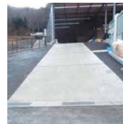
コンクリート舗装工事
