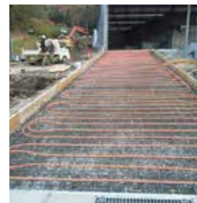
架橋ポリエチレンパイプの布設工事
